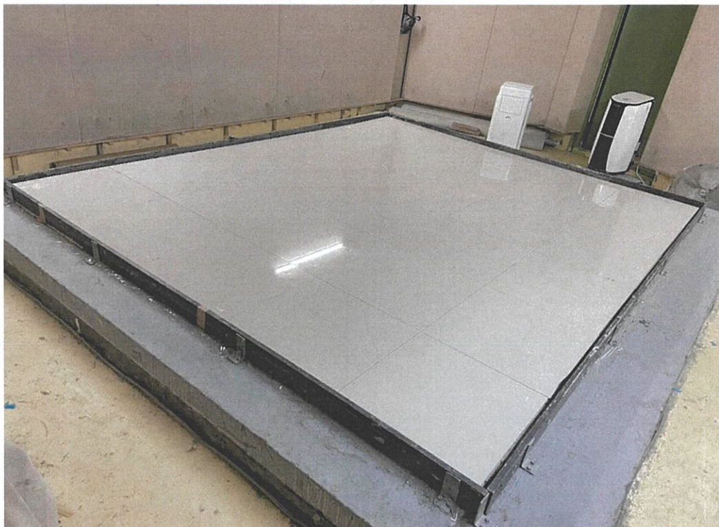
圖6.4 試件施工完成
