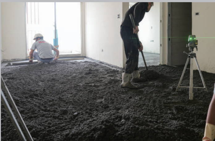
5. 隔音砂漿耙平施工
