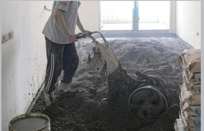
4. 直接拌合隔音砂漿
