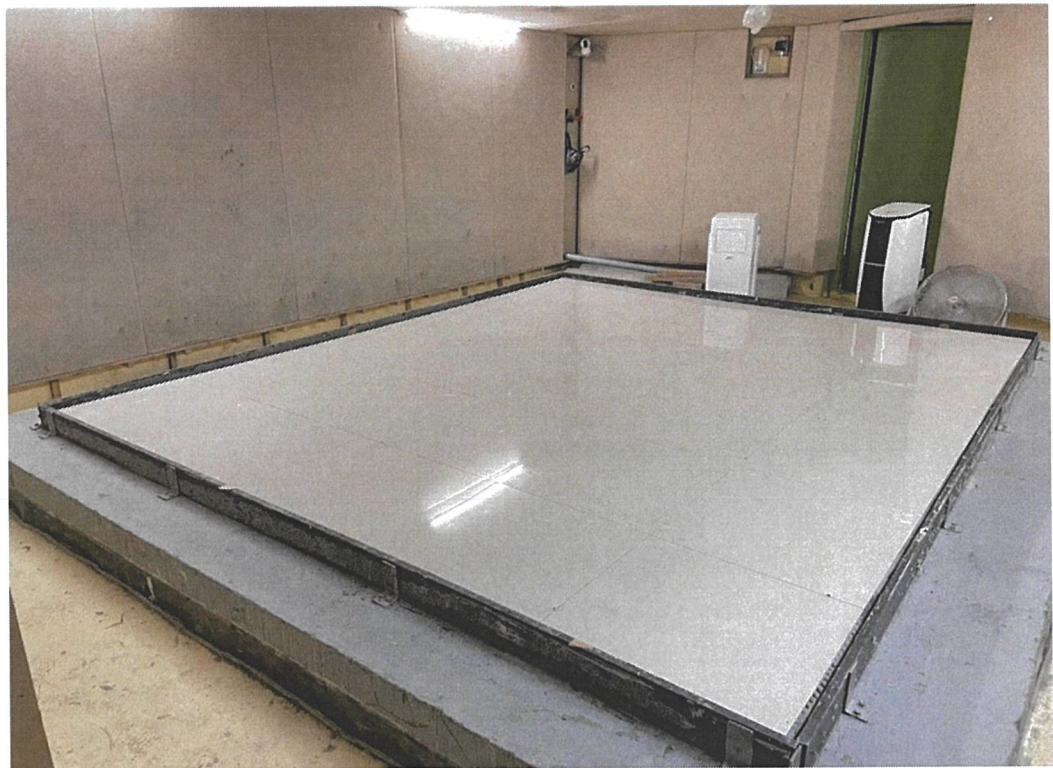
圖6.4 試件施工完成
